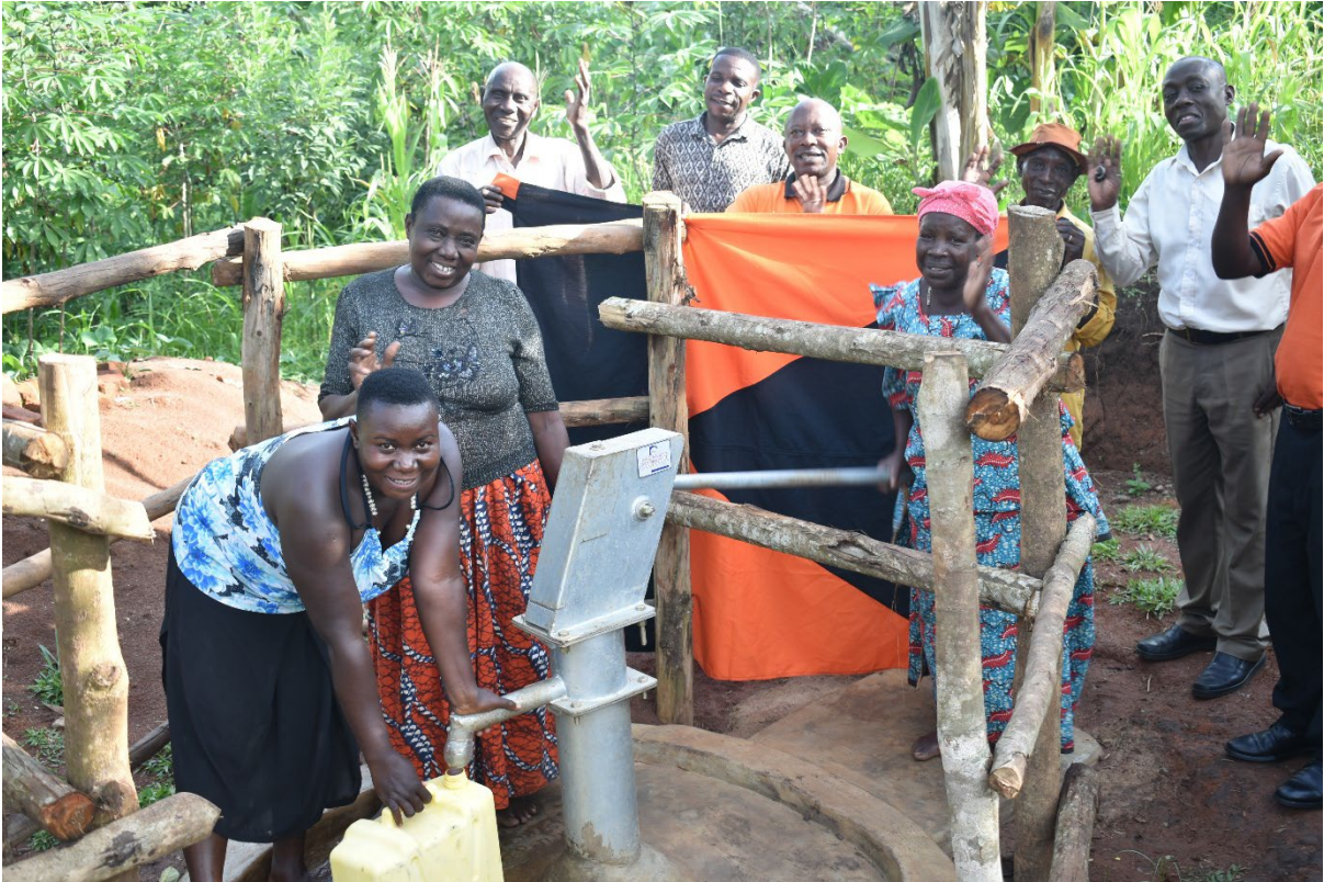
Flachbrunnen haben den Gemeinschaften den Zugang zu sauberem und sicherem Wasser ermöglicht.
